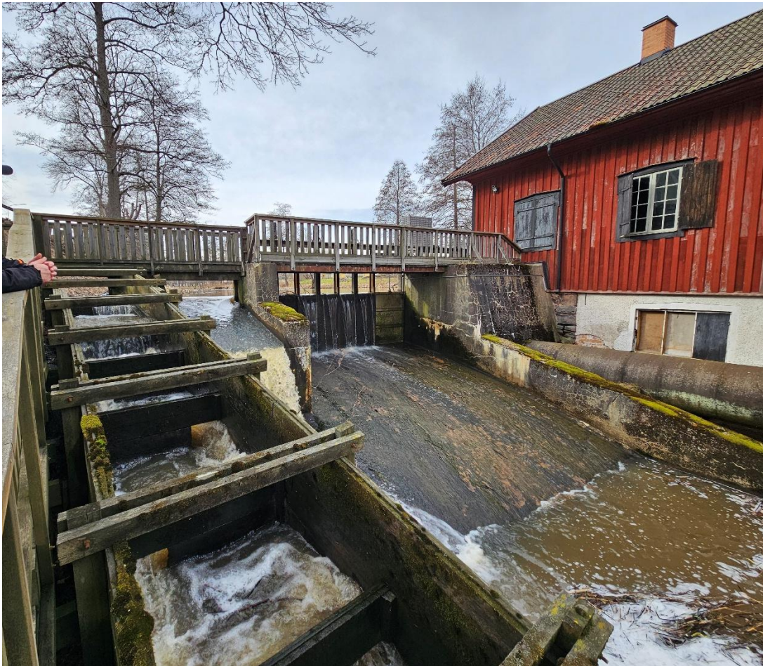
Figur 2 Befintlig kvarndamm med fisktrappa i förgrunden, luckor med bottenutskov och närmast kvarnbyggnaden turbinröret.
