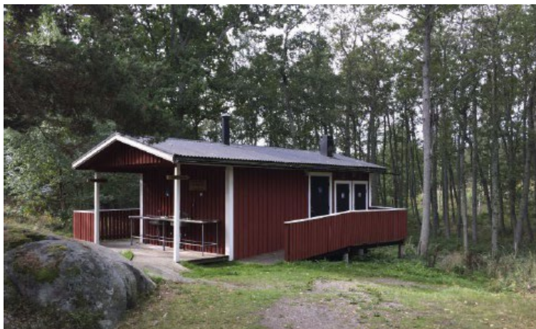
Figur 12: Bilden visar befintligt sanitetshus. Källa: Valdemarsviks kommun, september 2017.
