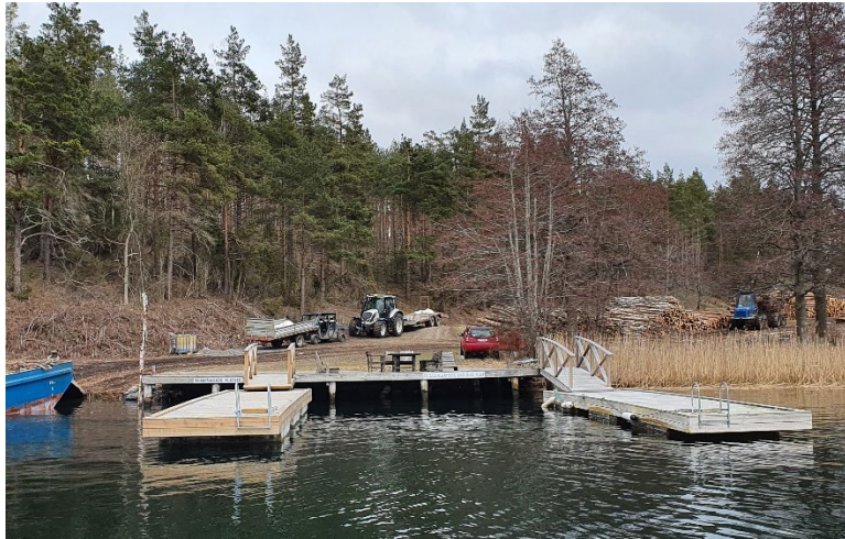
Bild 3 Befintlig brygga i planområdets västra del. Till vänster i bild syns en anlagd pråm för frakt av virke.
