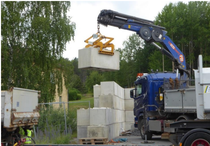
Figur 14. Foto från installation av sedimentationsdamm med hjälp av legoformade betongblock.
