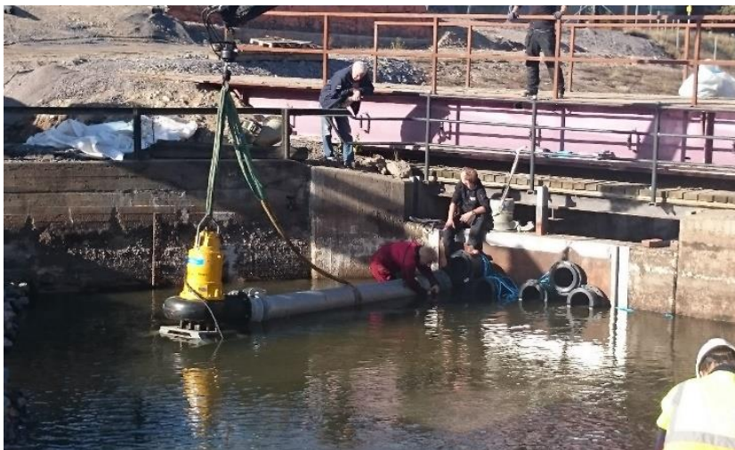
Figur 22. Installation av pumpar i samband med förbiledning av vatten.
