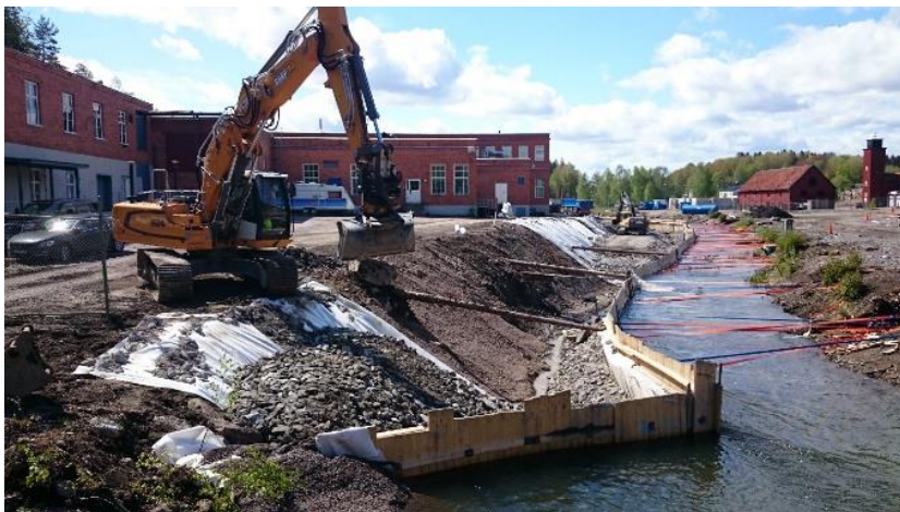
Figur 8. Schaktarbete vid den östra kanten av Gusumsån.
