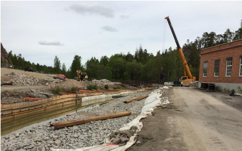
Figur 19. Foto på arbete med återfyllning.
