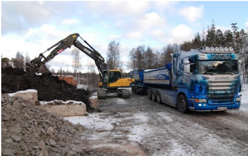
Figur 17. Sortering och lastning av uppgrävda massor.
