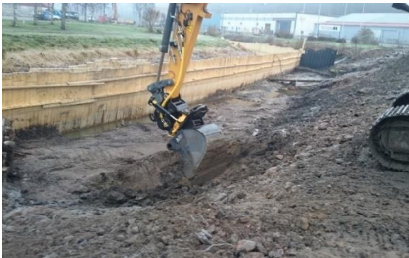
Figur 13. Foton från påbörjad schakt efter avslutad torrläggning av spontad sektion.
