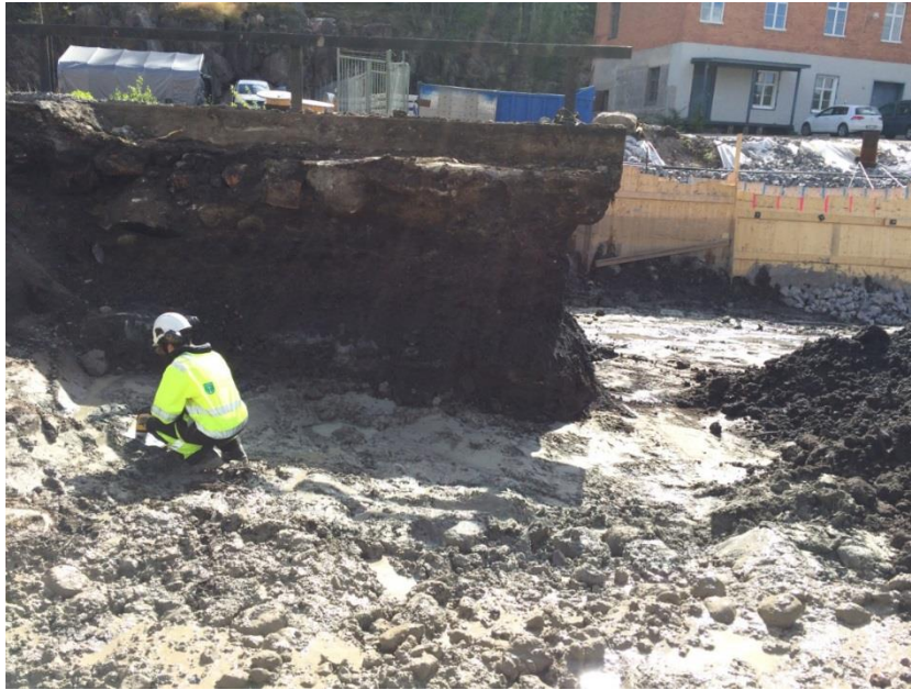
Figur 27. Kontroll av schaktbotten.
