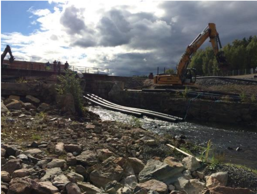
Figur 21. Förbiledning av Gusumsån i anslutning till Bruksdammen.
