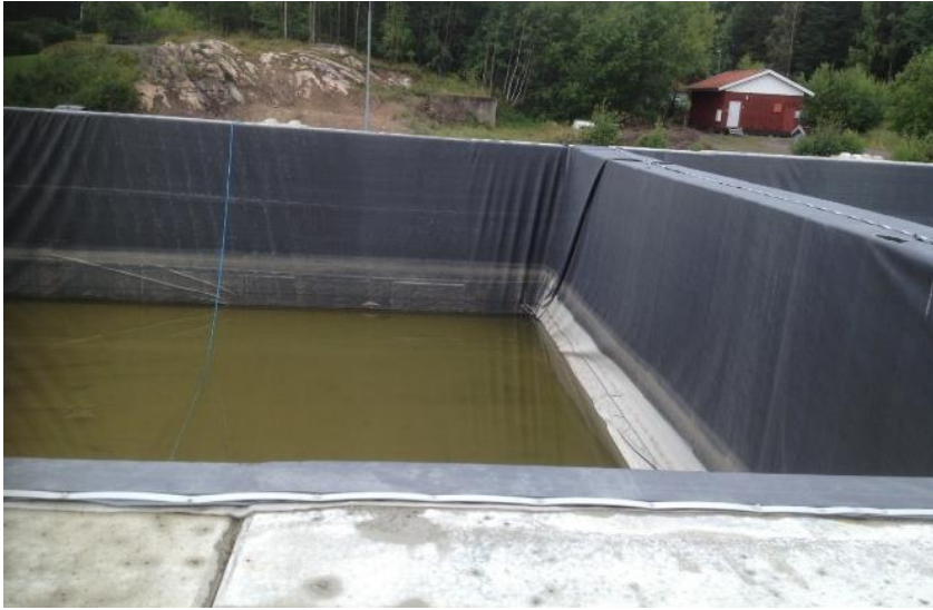
Figur 16. Foton från insida av sedimentationsbassäng.
