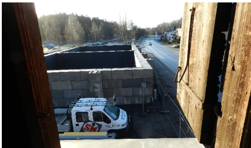
Figur 15. Foto taget från insidan av den s.k. röda ladan, söderut mot de två färdigställda sedimentationsdammarna.
