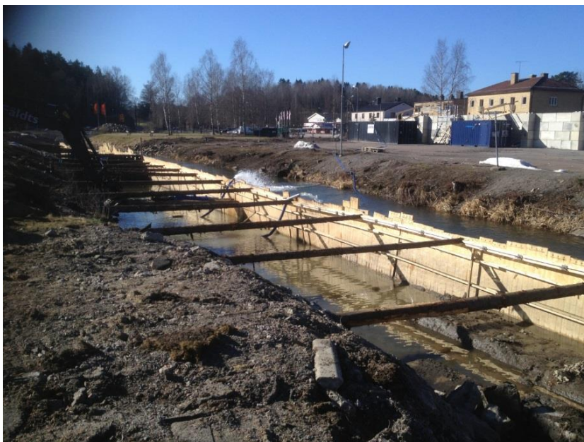
Figur 11. Foto av spont med s.k. stämpor som installerats för att stabilisera spanten vid höga vattenflöden.
