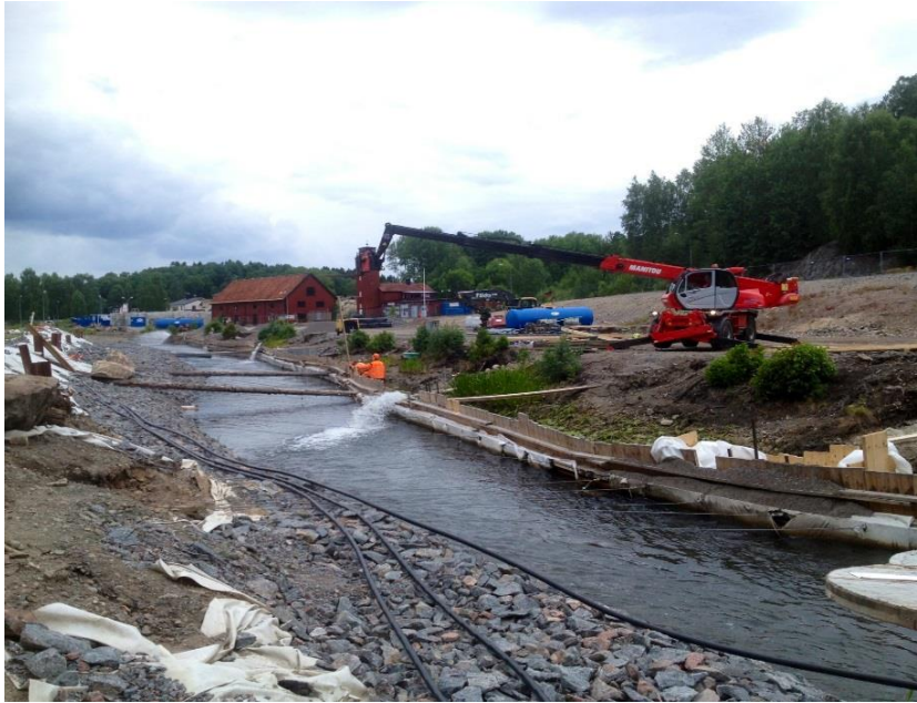
Figur 12. Foto från torrläggning av spontsektion genom länshållning.
