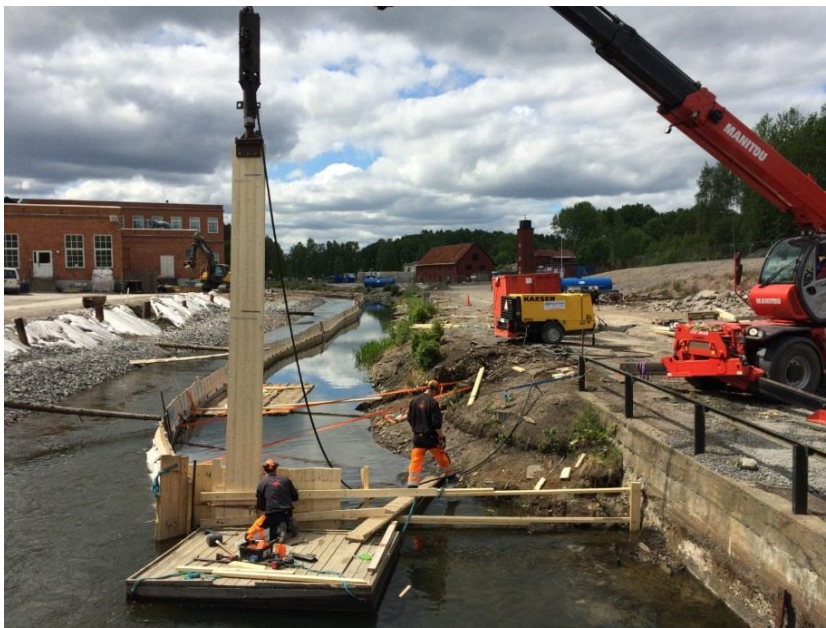
Figur 10. Foto från arbete med installation av spontvinge med mobil kran.
