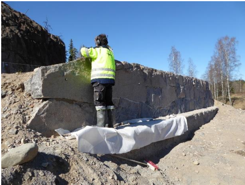
Figur 25. Stenmur som restaurerats genom blästring och stabilisering.
