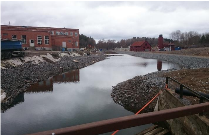
Figur 20. Foto på återskapad vattenspiegel motsvarande som det såg ut under tidigt 1900-tal, samt erosionsskydd i åkant.
