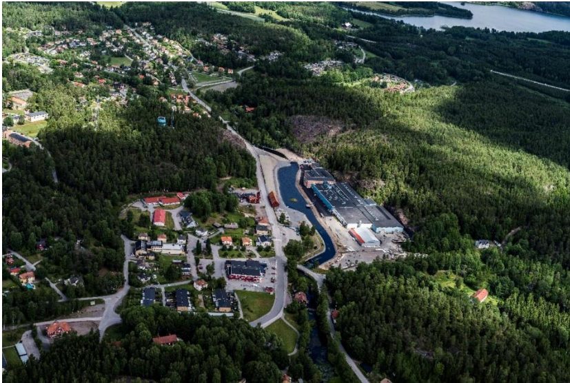
Figur 1. Lokalisering av det gamla Bruksområdet efter avslutad sanering (juli 2016). Öster är till höger i bild och Gusumsån rinner i nordlig riktning genom bruksområdet.
