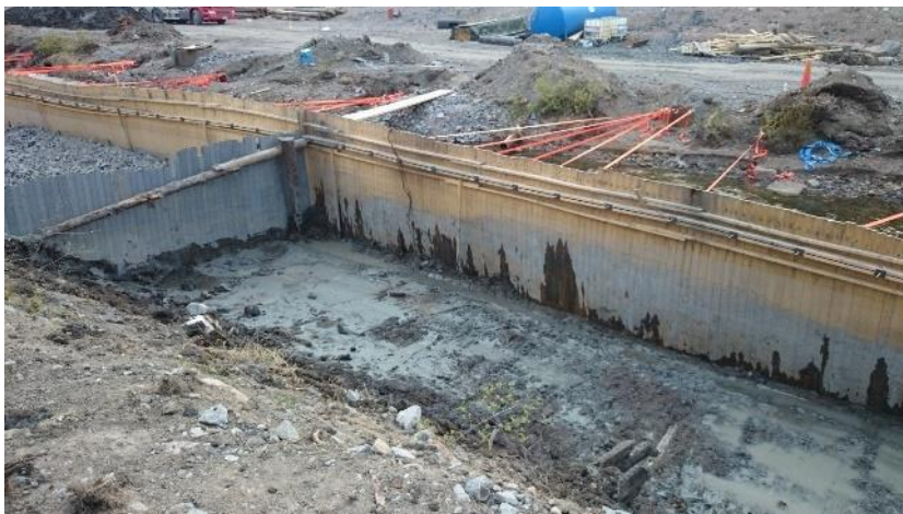
Figur 9. Foton från schaktarbeten i Gusumsån.
