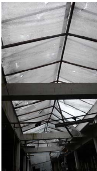
Figur 18. Undvik provtagningsarbete rakt under lanterninerna.
