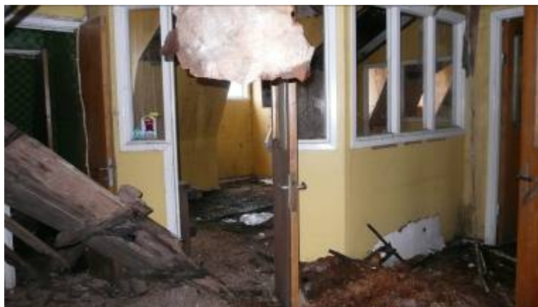
Figur 9. Övre våning. Labbdelen ska inte beträdas. Golvet är mycket dåligt och risken att falla igenom är mycket stor.
