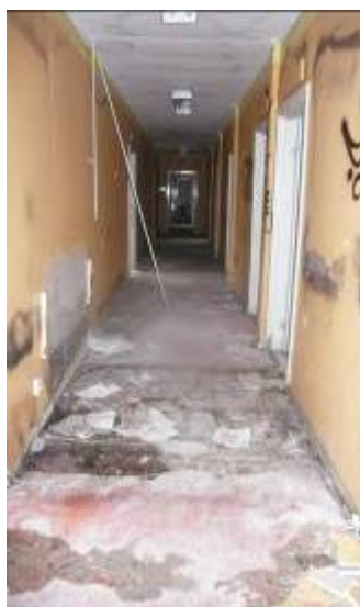
Figur 8. Mellenvåning. Kontorsdelen ska inte beträddas. Golvet är mycket dåligt och risken att falla igenom är mycket stor.
