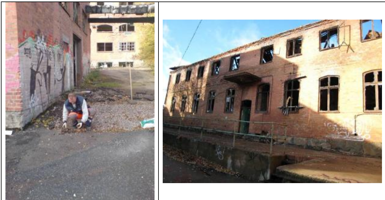
Figur 11 Foto som visar asfalt av dålig kvalitet (t. v.) samt förfall av byggnader (t. h.).
