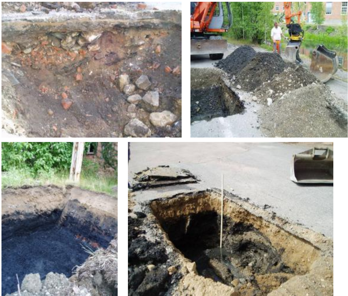
Figur 21. Foton på olika typer av fyllnadsjord förekommande inom f d Gusums bruk. Lokalt förekommer tydliga skikt som möjliggör en separering och förorenade massor redan vid schaktning.
