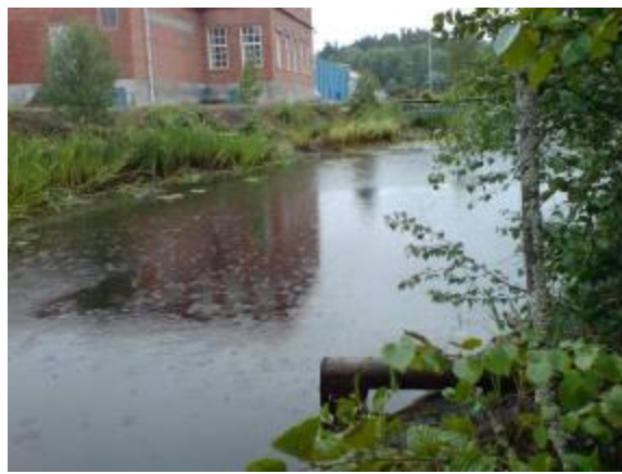
Figur 8 T. v. fyllning i åbrinken (spridning via erosion och dagvatten). T. h. ledning ut i Gusumsån (spridning av slam).
