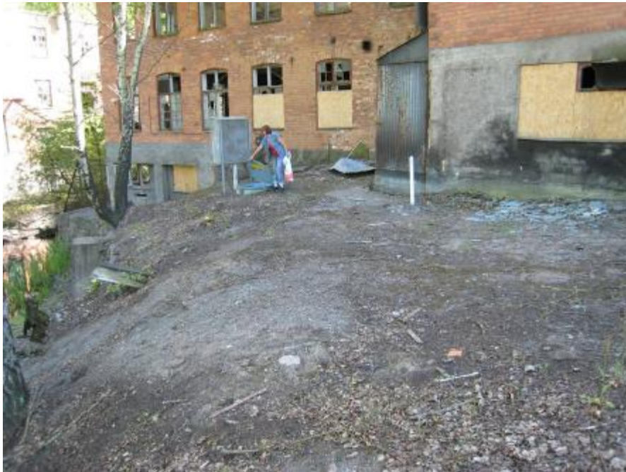
Figur 12 Foto från området norr om bruksbyggnaderna där stabiliteten i den förorenade fyllningen inte är tillfyllest.
