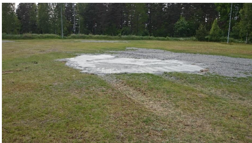
Figur 3. Bilden visar hur provgropar återställts efter provgropsgrävning, Spånskivedeponin Valdemarsvik.
