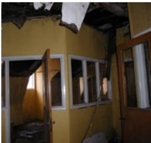
Bild 1: Byggnad C på den övre våningen, Gusums bruks gamla laboratorium.
