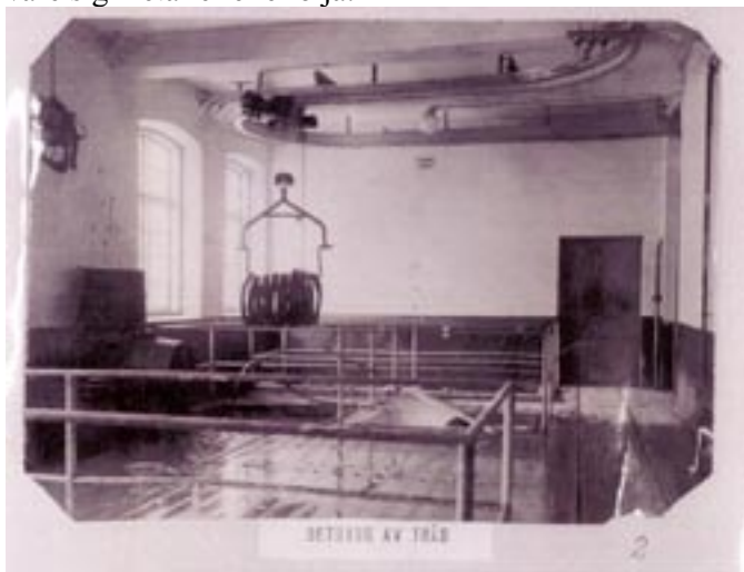
Bild 3: Byggnad E Syrabetning av tråd. Borrhål 10 placerades precis under linan i det här rummet. I källarvåningen precis under ligger sedimenteringsbassängen (Borrhål 8 placerades i sedimenteringsbassängen) (1944). Bilden är hämtad från Gusums Bruksmuseum.
