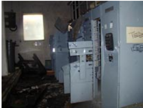
Bild 5 o 6: Bottenvåningen på byggnad F, här har det tidigare skett förtenning av produkter. Olja detekterades i betonggolvet. Bild 6 visar resterna av transformatorstationen..
