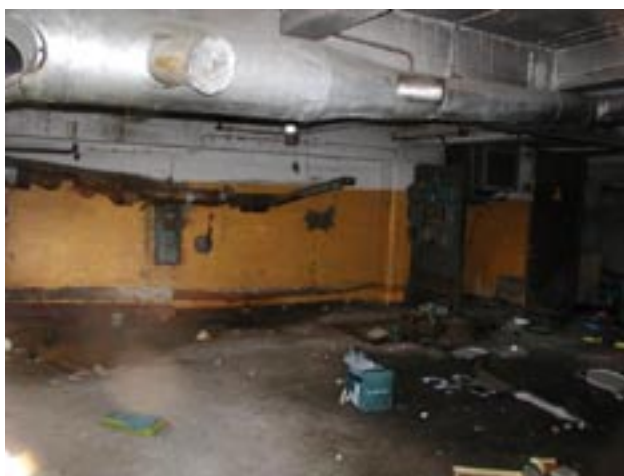
Bild4: Norra delen av byggnad D i det rummet där det tidigare funnits en oljeugn.
