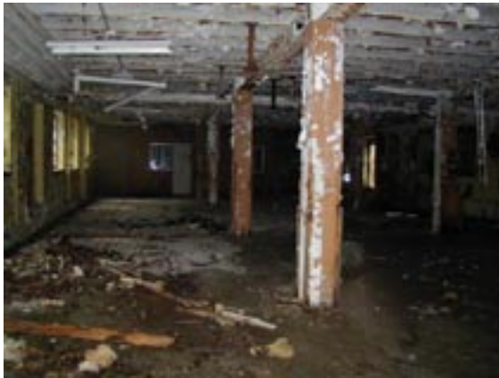
Bild 5 o 6: Bottenvåningen på byggnad F, här har det tidigare skett förtenning av produkter. Olja detekterades i betonggolvet. Bild 6 visar resterna av transformatorstationen..
