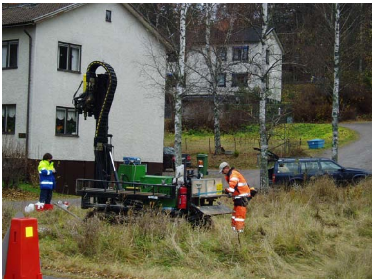
Sättning av grundvattenrör vid GS 3. Foto: Samir Ezziyani, SGI
