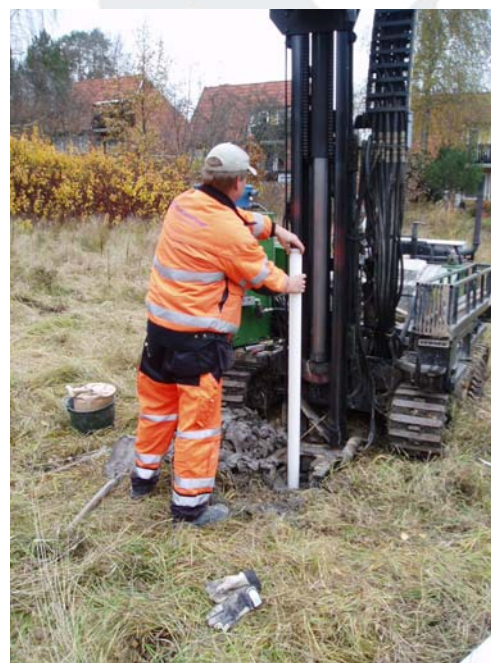
Sättning av grundvattenrör vid GS 3. Foto: Samir Ezziyani, SGI
