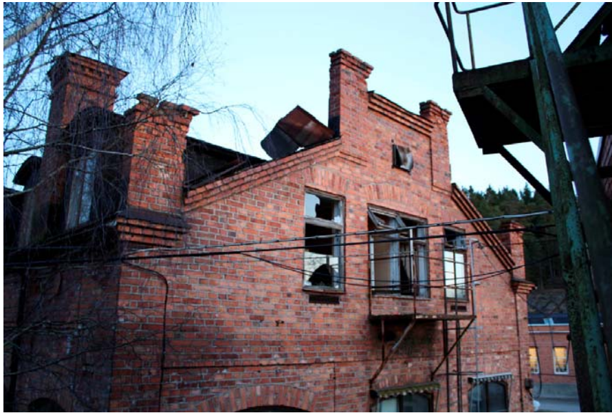
Skorstensliknande dekorativa krönavslutningar med enkla listverk och tunna stödmurar är en rest från det formspråk som präglade områdets byggnader på 1910-talet. Södra gaveln av byggnad C, vars stickbågiga fönstervall ersatts med rektangulära fönster då våningens laboratorium utökades på 1950-talet. Foto: AL 2008-11-17
