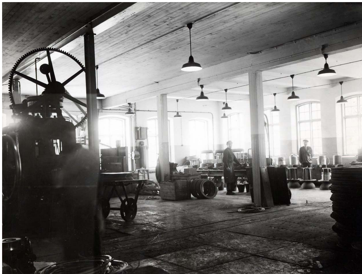
Interiör från grovtråddrageriets nybyggda lokaler 1937 på våning ett. Till vänster syns valsverket, där gjutna metallplattor valsades innan de skars till fyrkantig tråd, sk. realtråd, som drogs till mindre dimensioner i tråddragningsbänkarna till höger i bild. Golvet var belagt av plåt och genom lokalen löper ett industrijärnvägsspår. Bilden utlånad av Gusums bruksmuseum.
