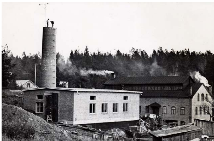
Värmecentralen sedd från väst under uppförande 1951. Den stora skorstenen är inte färdigmurad utan ännu ryker det ur de mindre skorstenarna vid respektive byggnad. De mindre värmepannorna ersattes av det centrala värmesystemet som togs i bruk 1952. I bakgrunden åt höger syns hus B i sitt utprägnade Bilden utlånad av Börje Delborn, Gusum.
