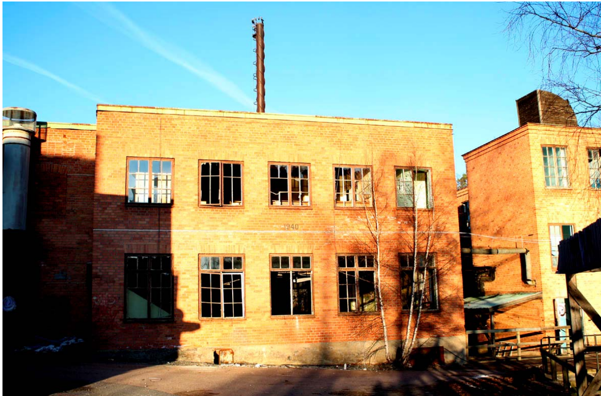
Den strama funktionalistiska fasaden mot söder som byggnad L fick då kraftstationen påbyggdes 1940 och därmed blev en del av byggnad K . Foto: AL 2008-11-17
