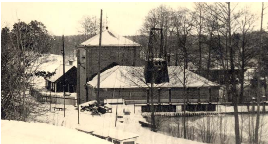
Vid det högre vattenfallet vid Ursätter togs en större kraftstation i drift 1906. Tidigare låg här järnbruket och därefter ett privat ullspinneri. På bilden syns kraftstationen med transformatorn från väst år 1946, några år före dess nedläggning. Bilden utlånad av Gusums Bruksmuseum.
