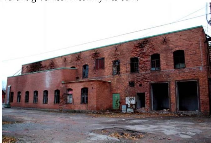
Byggnad B sedd från nordöst. Övervåningen revs bort 1954 då huset byggdes om till smälthytta. Den större utbyggnaden från 1960 syns till vänster och till höger syns de två utrymmena för smältverkets transformatorer. Den mindre utbyggnaden i mitten tillkom runt 1940 som en del av sprutlackeringsavdelningen. Foto: AL 2008-10-20
