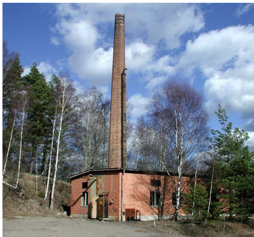
50 år senare släcktes pannorna för sista gången och förvuxet sly bäddar nu in byggnaden i slänten. Panncentralen sedd från väst. Foto: AL 2003-03-30
