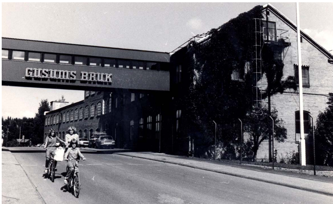
Kontorsbyggnaden med gångbron över Bruksgatan sedd från sydväst. Gångbron utgjorde en portal till bruket men raserades av misstag 1979. En ny identisk bro stod klar ett halvår senare. Foto: Sven Delborn, augusti 1980.
