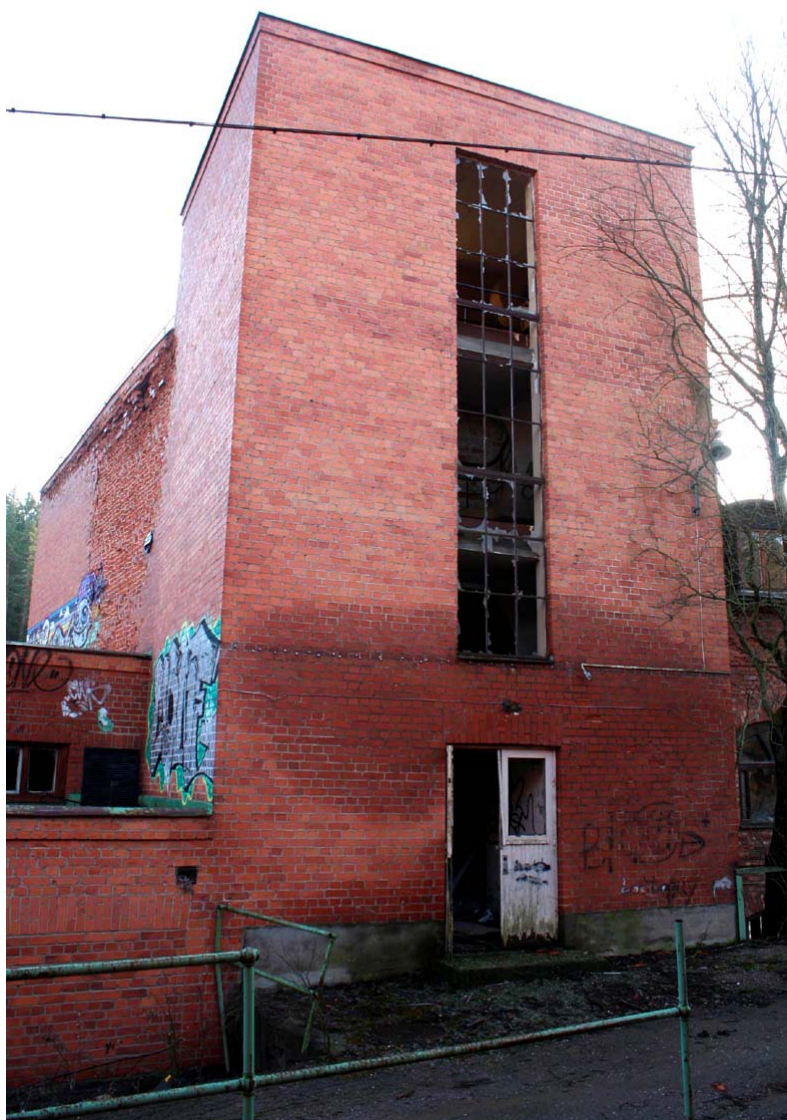
Byggnad D med dess trapphus vars stora fönster på västra gaveln är tydligt markerat i fasaden. Byggnaden uppfördes samtidigt som hus E och inrymde personalutrymmen, smedja och plåtslageri. Från trapphuset leder dörrar till våning två och tre i byggnad C. Foto: AL 2008-12-18
