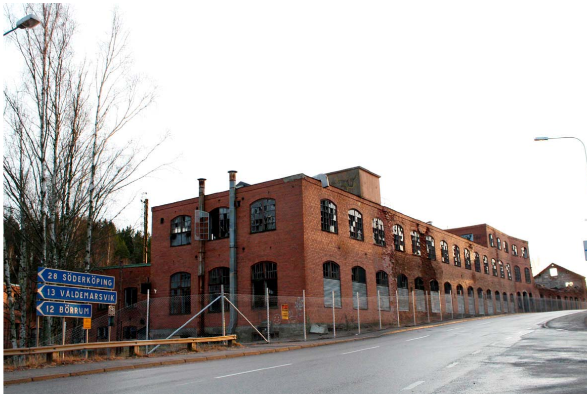
Byggnad H sedd från norr. Den tredje våningen i byggnad H och G syns till höger och det eldhärjade kontorets gavel står kvar som en tom kuliss från det spel som ledde fram till konkursen 1988. På den norra gaveln syns rester av ventilationstrummor från hårdverkstaden i källarvåningen. Lägg även märke till hissmaskinrummet på taket. Foto: AL 2008-12-21
