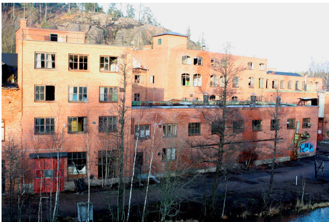
Byggnaderna D och E sedda från öster. De båda byggnaderna uppfördes samtidigt 1944. Den högre delen till vänster (hus D) inrymde omklädningsrum och den lägre delen åt höger smälthytta (hus E). Fönstrena på byggnad E minskades då lokalen byggdes om till centralverkstad sedan smältverk och gjuteri flyttat. I bakgrunden syns fasaderna på byggnaderna G och H. Foto: AL 2008-12-18
