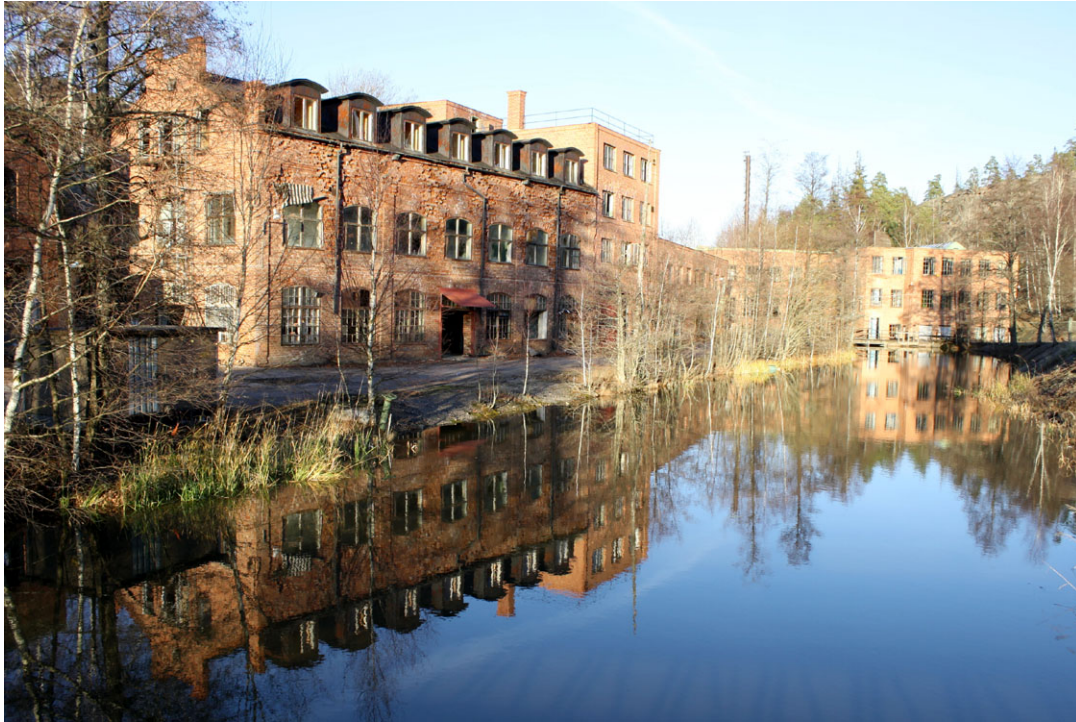
Vy från söder mot byggnad C som avspeglas i Gusumsåns vatten. De karaktäristiska takkuporna ger skarp kontrast mot det annars dominerande funktionalistiska formspråket på området. Från byggnadens laboratorium släpptes orenade kemikalier ut i ån. I bakgrunden syns byggnaderna D, E, L och M. Foto: AL 2008-11-17
