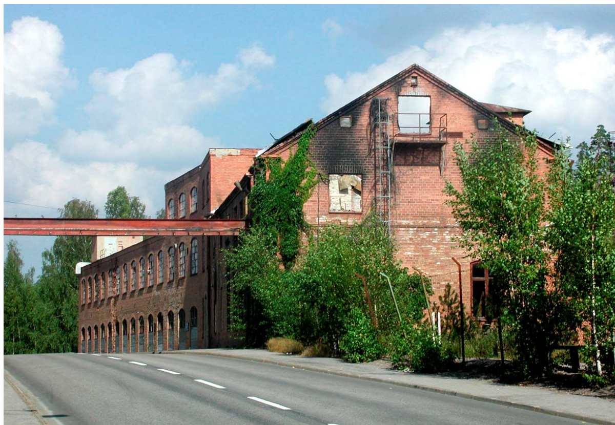
På grund av bristande underhåll och en omfattande vandalism kom de gamla bruksbyggnaderna att förfalla i snabb takt. Genom en brand i mars 2002 förvandlades kontoret utmed Bruksgatan till en ruin. Foto: AL 2002-08-29
