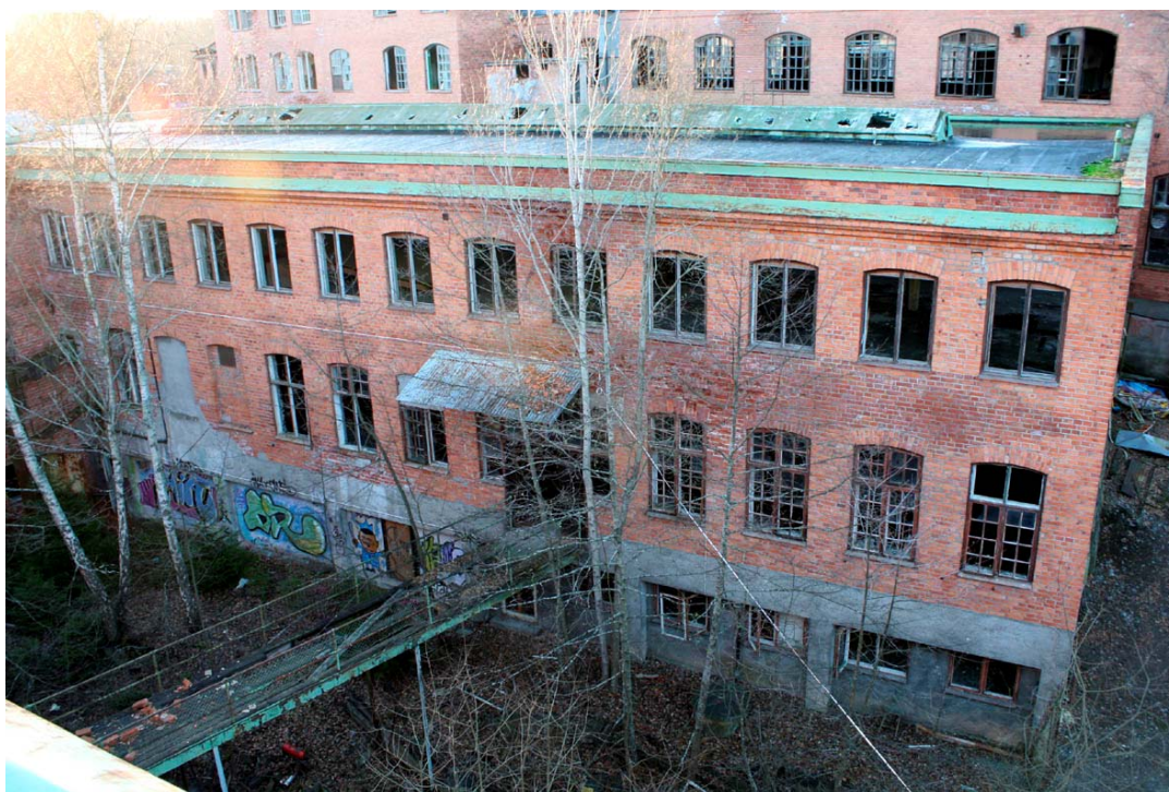
Byggnad K sedd från öst. Byggnaden breddades 1936 och det äldre bethuset flyttades in i tegelbyggnaden. Detta var beläget där gångbron går över ån mot byggnad M. Över bron transporterades blytlåsdetaljer från kramp- och förnicklingsavdelningarna i hus M, genom skär- och valsverksavdelningen i byggnad K och slutligen till hus H, där blytlåsen färdigställdes. Foto: AL 2008-11-17
