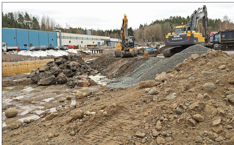
På västra sidan Bruksområdet schaktades fyllningen ur i sin helhet och ersattes med rena massor. Framför Röda Ladan återfick ån del av sin tidigare åfåra och den stora mängden block i fyllningen kunde bland annat användas till uppbyggandet av en ny ö.
