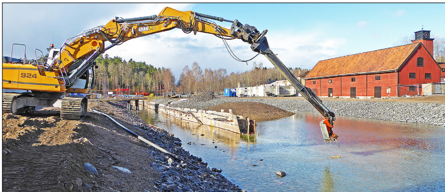
I början av april 2016 var saneringen på Bruksområdet klar och vattnet kunde åter släppas fritt i ån. Den 384 meter långa träsponten som under stora delar av saneringen möjliggjort schakt i torra massor, kunde därmed avetableras.
