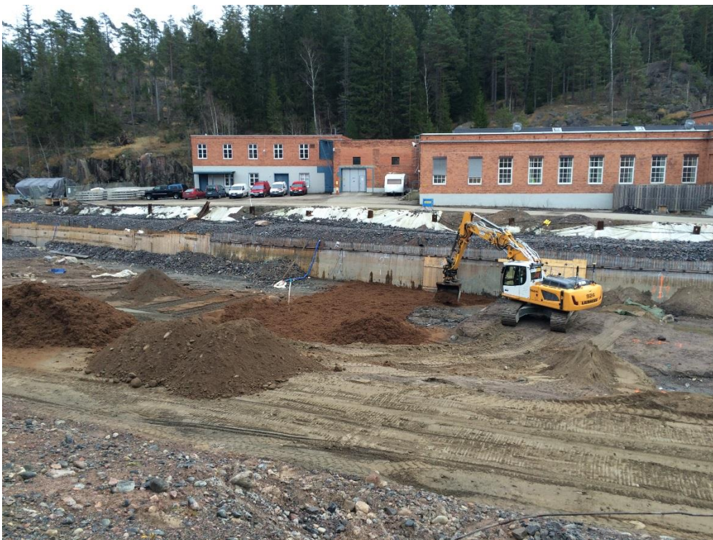
Figur 5 Utläggning av torv på lerområde med höga halter av klorerade alifater
