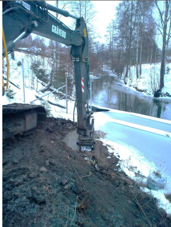
Schakt vi å-mynning innanför siltskärm.
