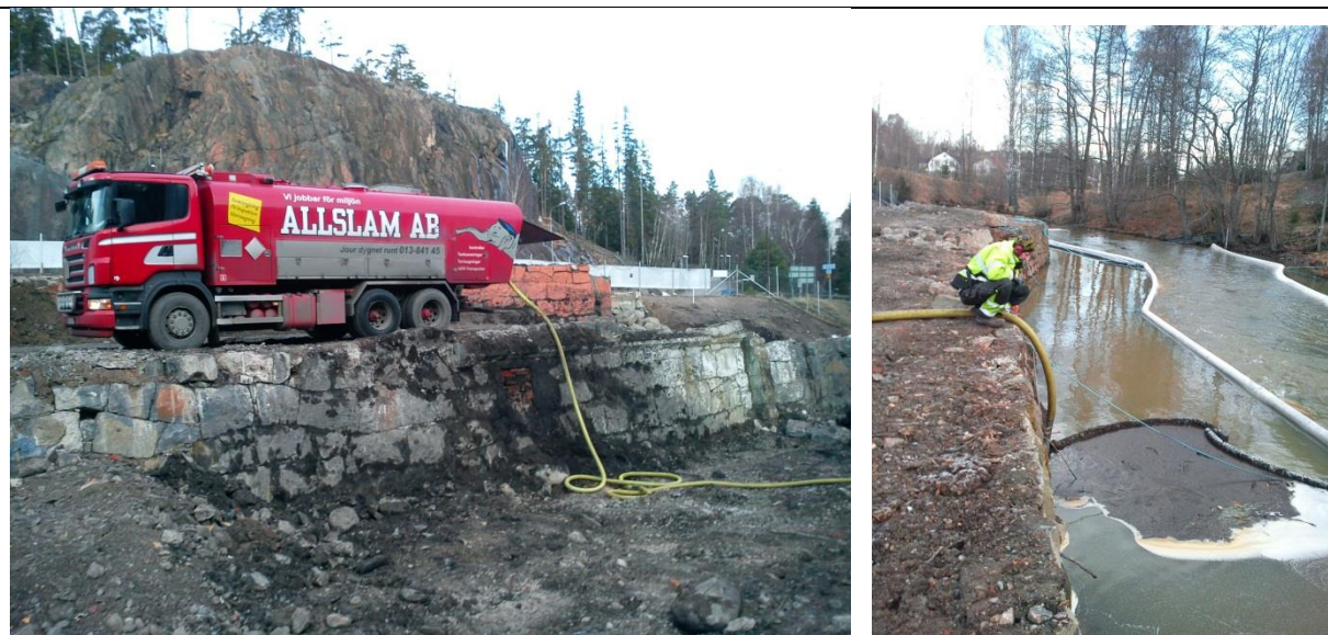
Figur 3 Sugning av flytabsol med olja i ruta 1:20.
