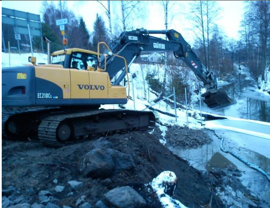
Stenfyllning i schaktad botten som erosionsskydd.
