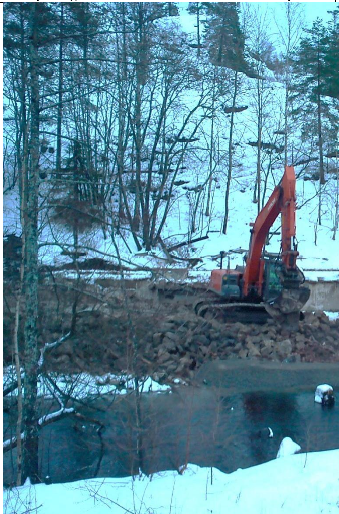
Vall med grus närmast ån som grumlingsskydd vid betongknackning och uppgrävning av stenfyllning
