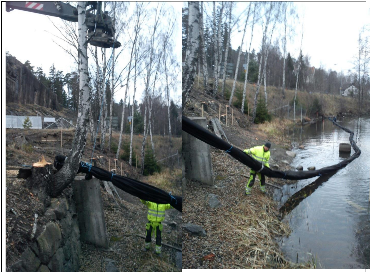
Utläggning av siltgardin 3/12
