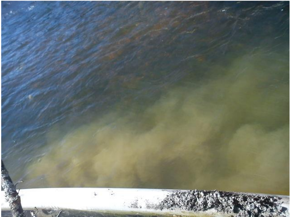
Grumling utanför siltskärm vid arbete östra sidan ån.
