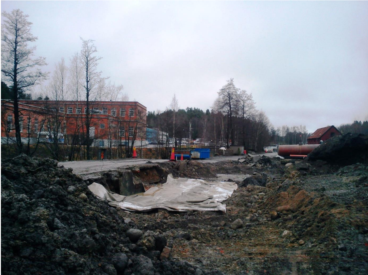
Bild1 Täckning av jord där PAH-förorenade (kreosotlukt) massor schaktats bort strax öster om ruta E3. Rutan tillhör etapp 2b och läggs igen med sten ovan geoduk etc. Bottenprov togs vid tidigare noterad brunn för analys av klorerade kolväten.
