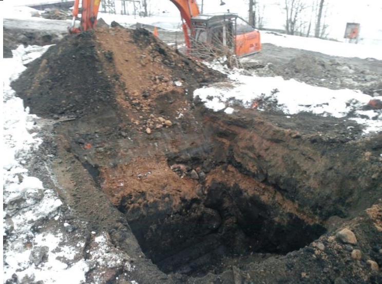
Figur 6 Provgrop i ruta F1 med fyllning med rivningsmassor och därunder svarta träkolsrester
