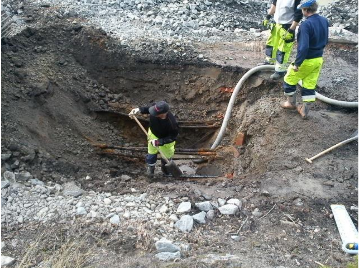
Åtgärd av vattenläcka
