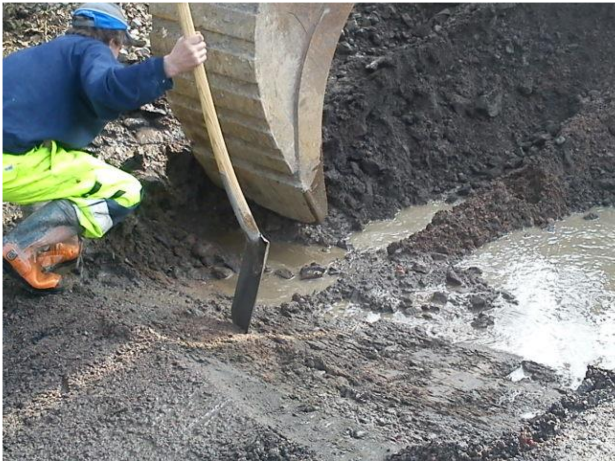
Åtgärd av vattenläcka, östra sidan.
