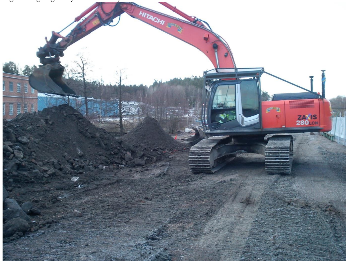
Figur 4 Siktning med gällerskopa i hus F.
