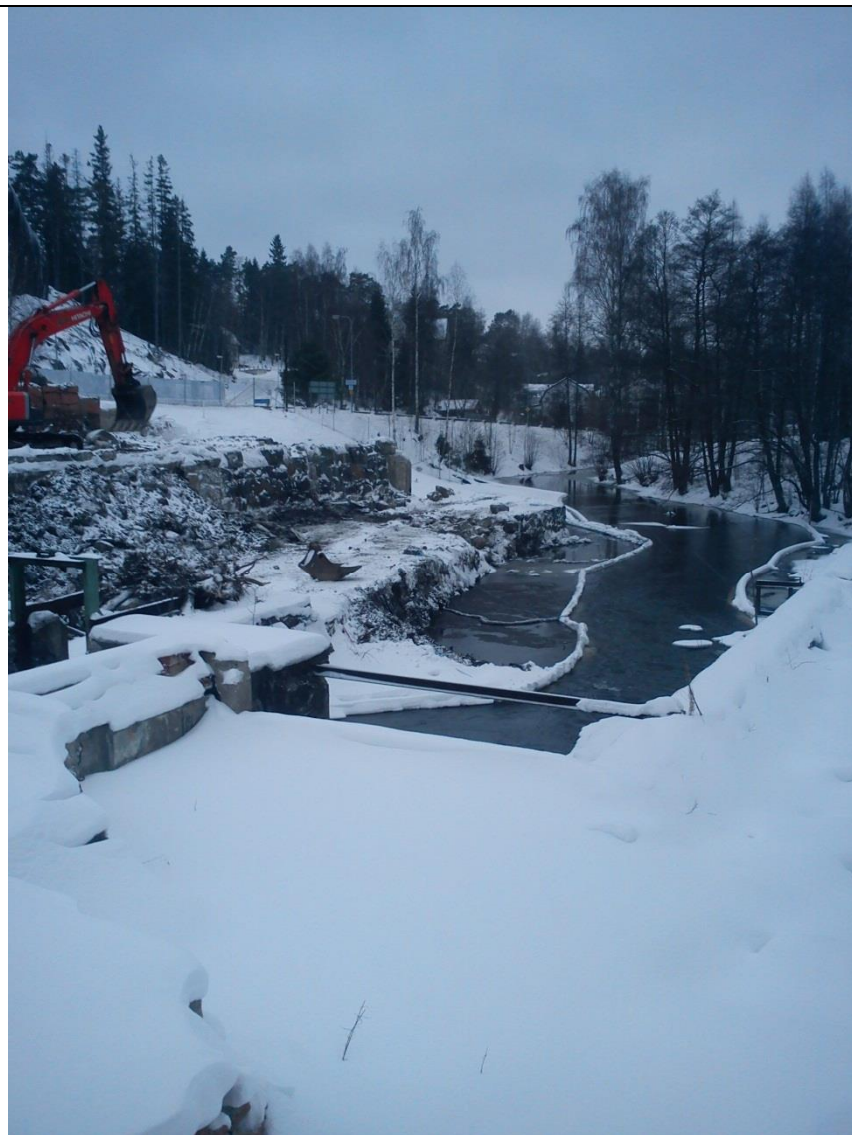
Figur 1 Schakt N om fördämningen, västra sidan
