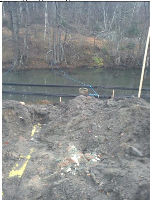
Massor med grön utfällning i N Slänten
