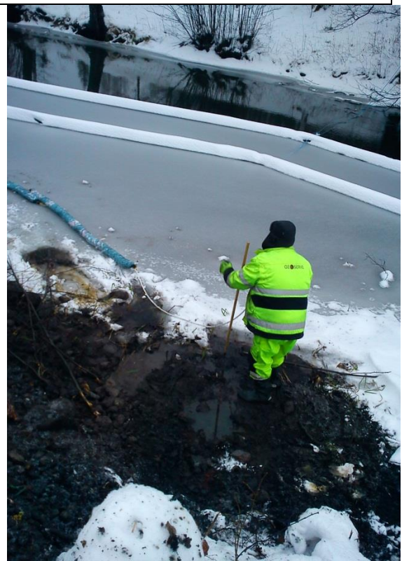
Utläggning av läns för att förebygga ev oljefilm då gv-rör H81 luktat "fotogen".
