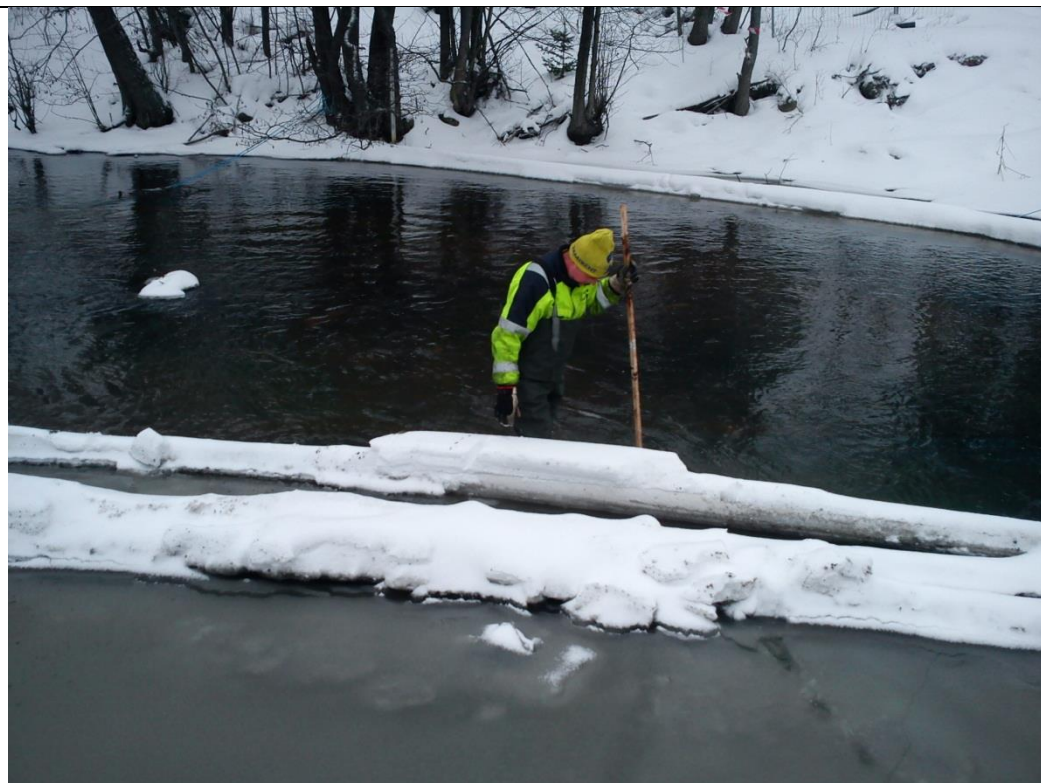
Figur 4 Läckage i siltgardin åtgärdas av Leo i vadarbyxor samt genom att hålla rengrus på utsidan av skärm.
