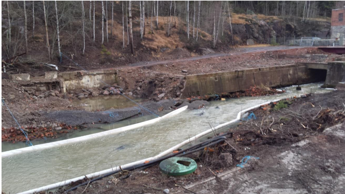
Bild 1. Tecomatic har installerat nya skärmar vid östra- och västrasidan.
