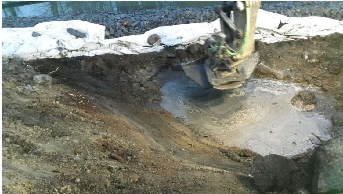
Bild 4. Kvarvarande massor i Norra slänten som täcks med geoduk och erosionsskydd.
