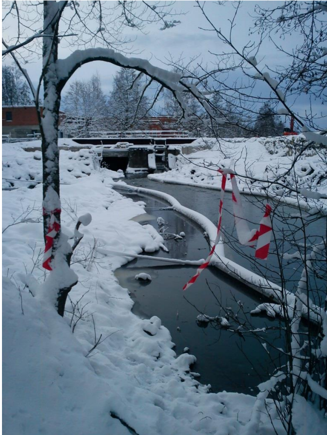
Bild 1. Tecomatic har installerat nya skärmar vid östra- och västrasidan.
