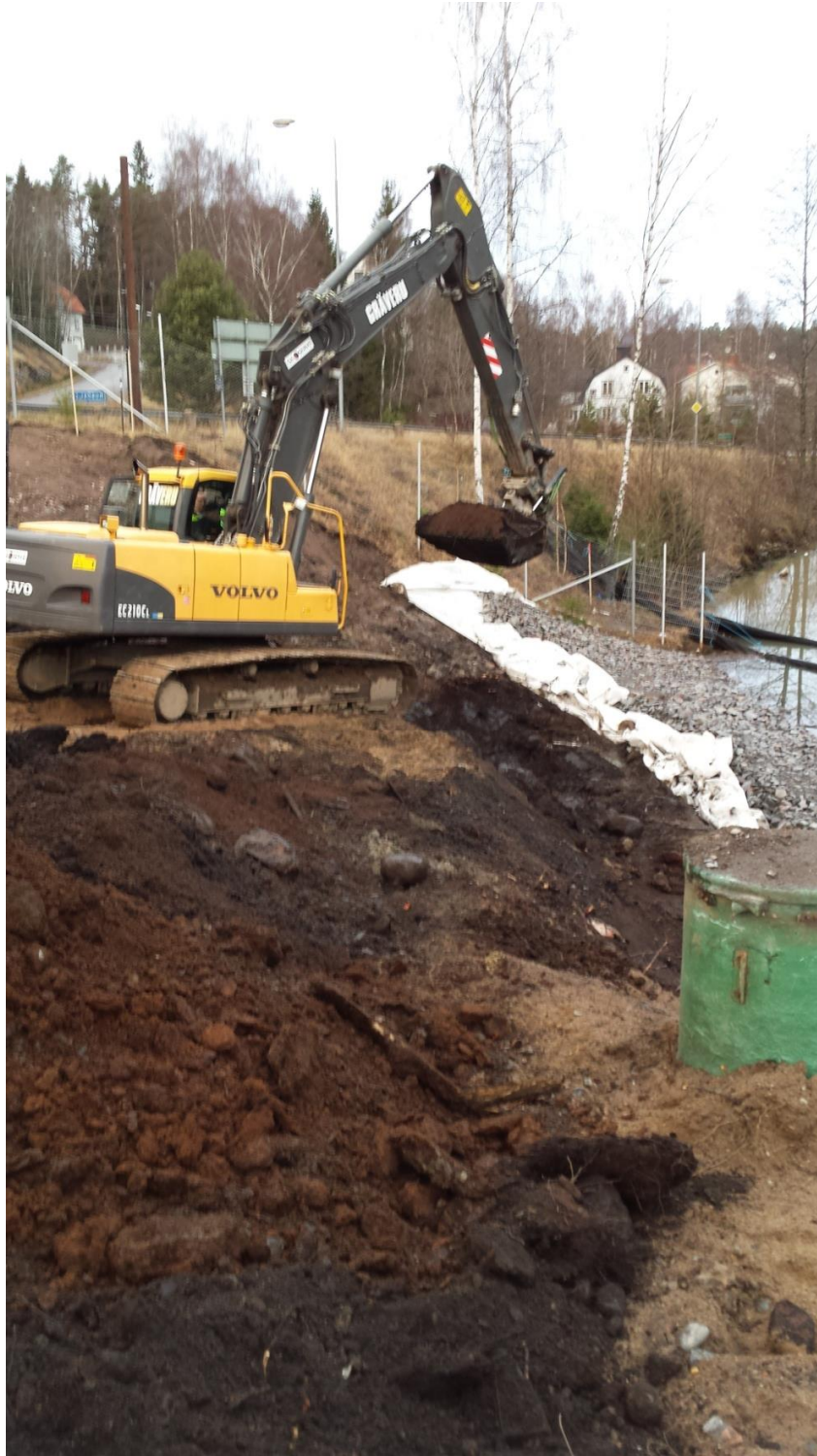
Bild3. Schaktning Norra slänten. I förgrunden finkorninga svarta massor samt rent sågspån.
