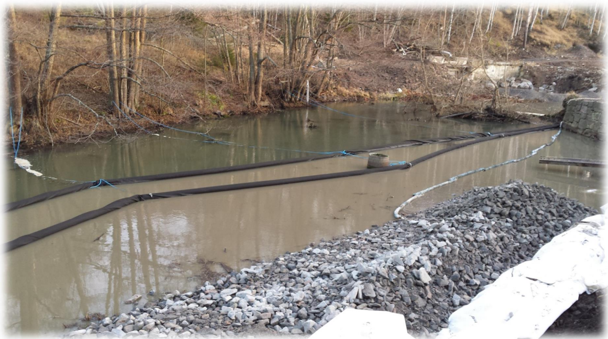
Bild 3 Schaktning och placering av erosionsskydd i N slänten.
