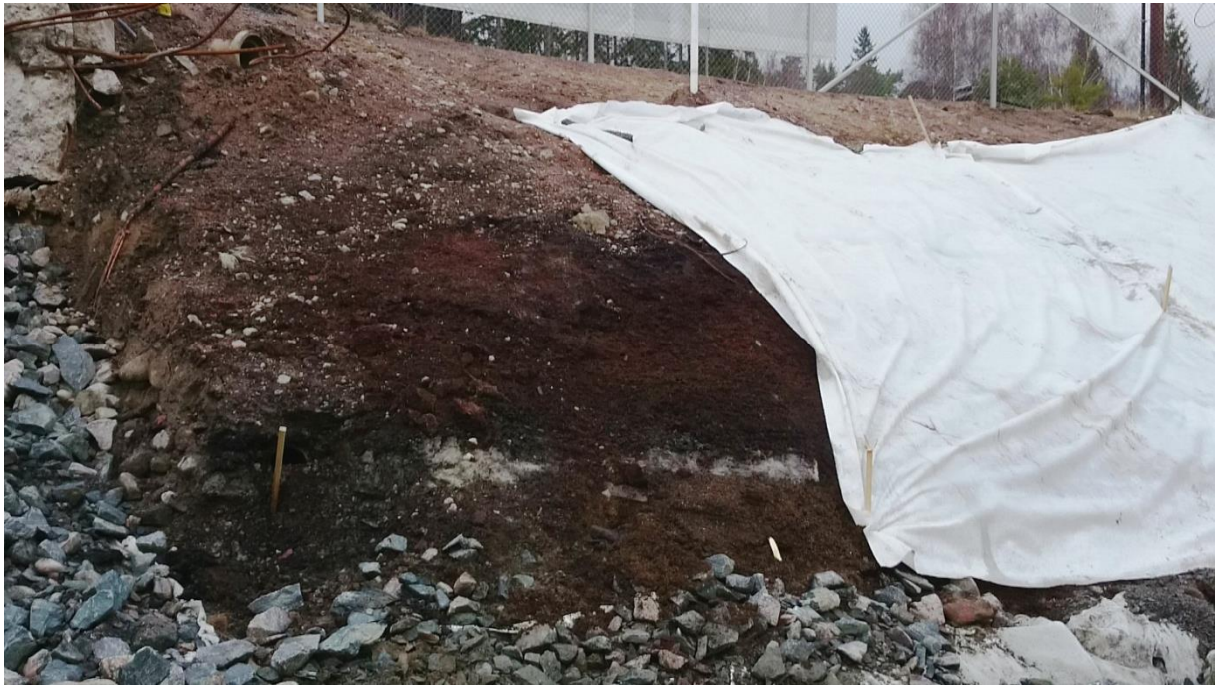
Lämnade föroreningar i norra slänten täcks med geoduk.
