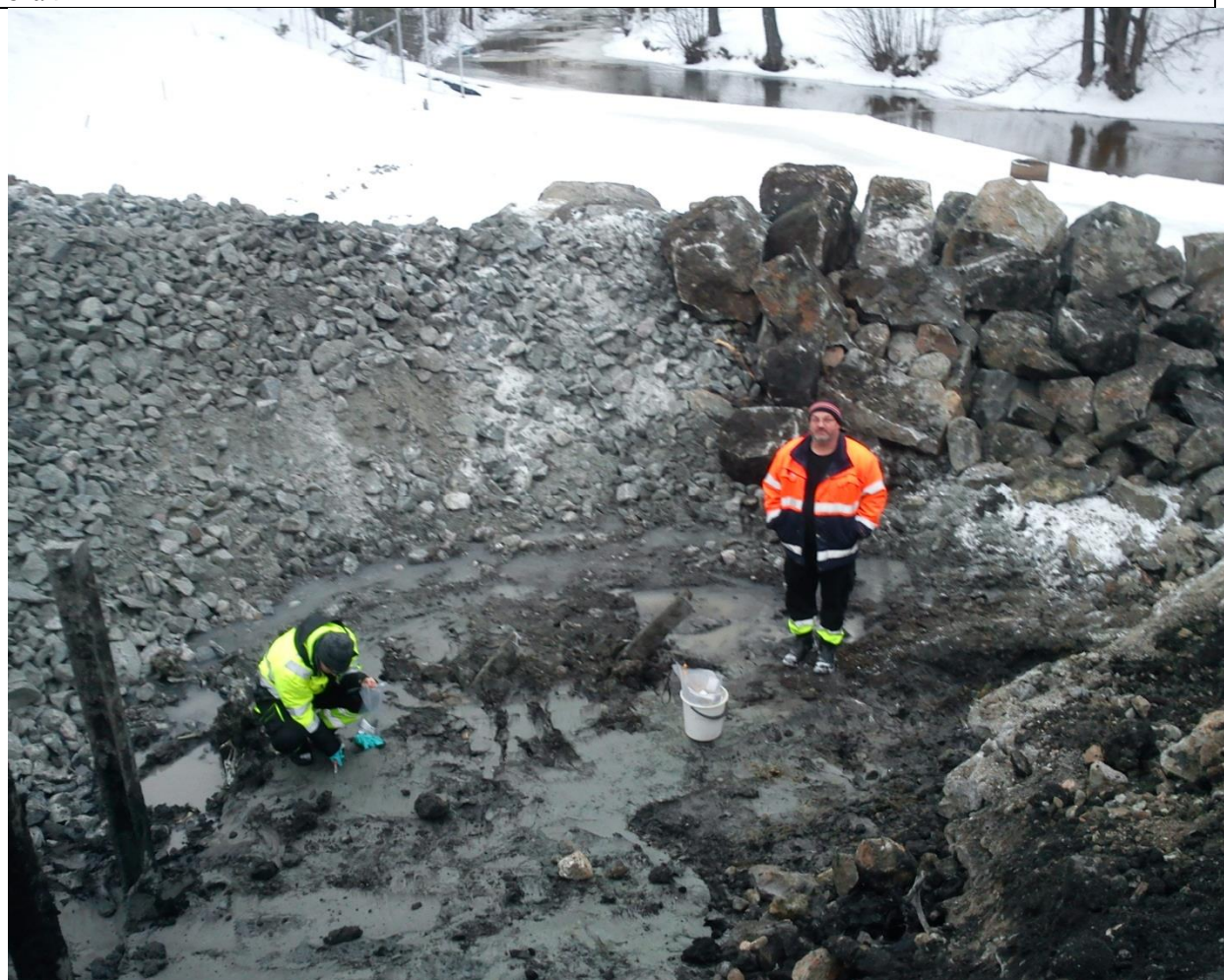
Figur 4 Läckage i siltgardin åtgärdas av Leo i vadarbyxor samt genom att hålla rengrus på utsidan av skärm.
