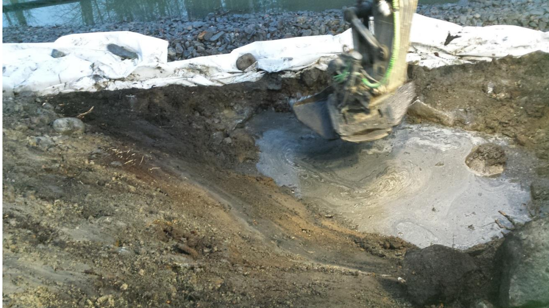
Bild 4. Kvarvarande massor i Norra slänten som täcks med geoduk och erosionsskydd.
