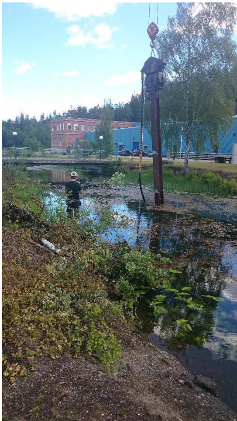
Figur 3 Neddrivning av balk i Gusumsån K-bron.
