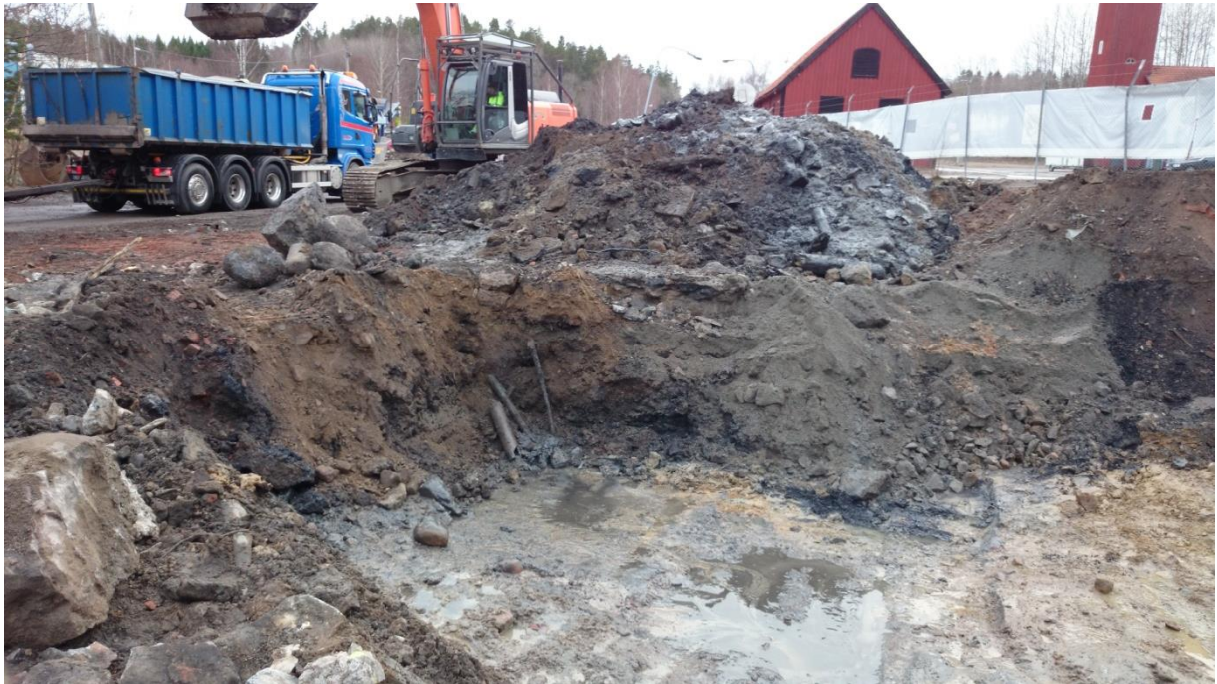
Schakthög med oljeförorenade massor. Ruta B1/2:1.
