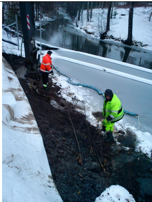
Utlägg av duk innan stenfyllning ned mot ån.
