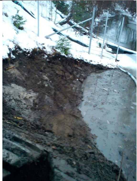
Sprängstensfyllning från vägbygge syns vid staket i NV slänten.
