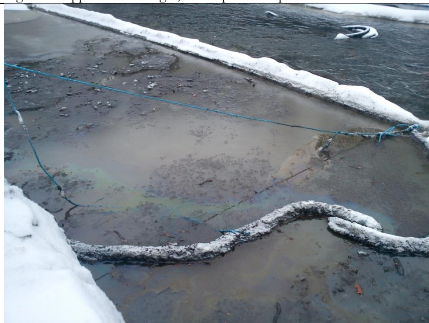
Figur 3 Oljeskimmer från murvägg i ruta 1:20 tas om hand med flytabsol och oljelänsar
