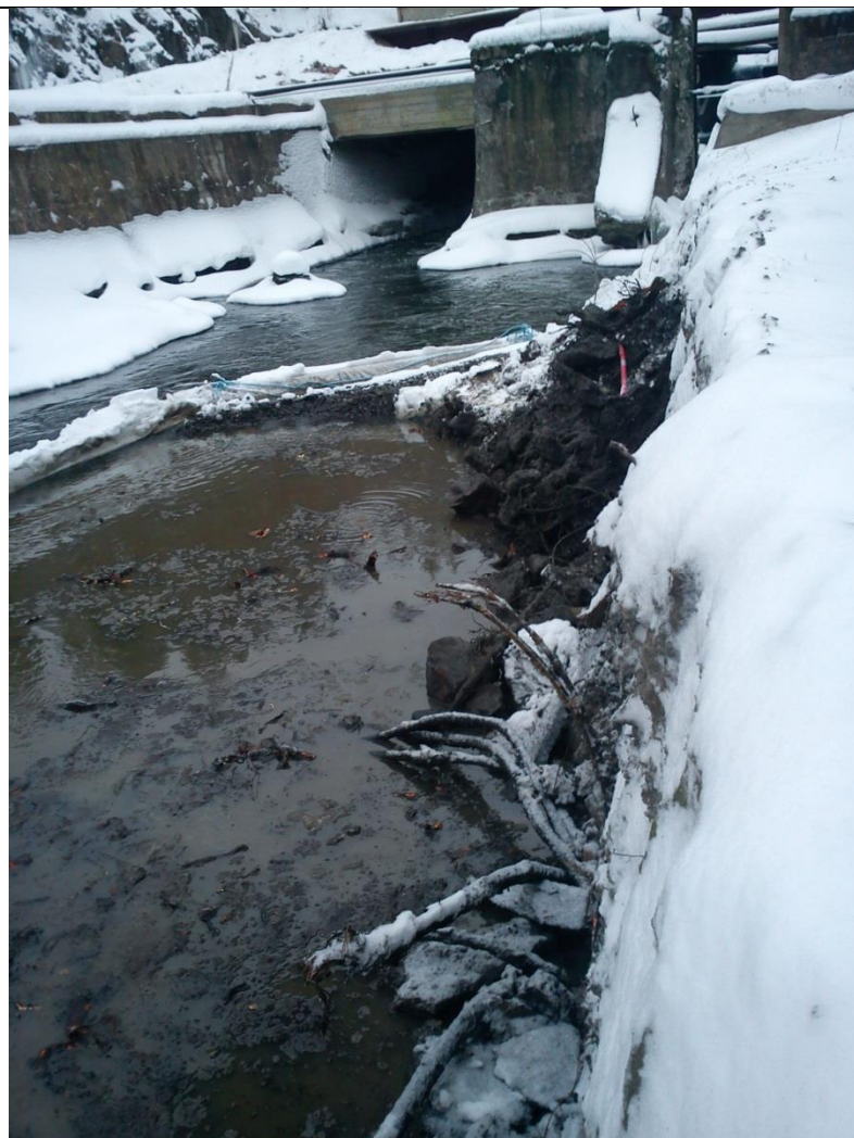
Figur 2 Knippe med ledningar, fick kapas då de påverkade siltskärmen
