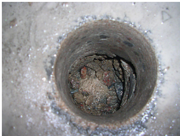
Bild 15. H105btg grus under golv, 2008-10-28.
