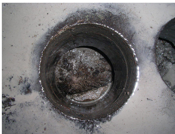
Bild 4. Hus V - V001btg, fingrus under golv, 2008-09-26.
