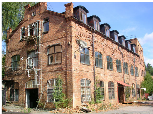
Bild 1. Hus C - södra och östra sidan 2008-09-02.
