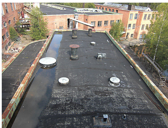
Bild 2. Hus E – tak 2008-09-02.
