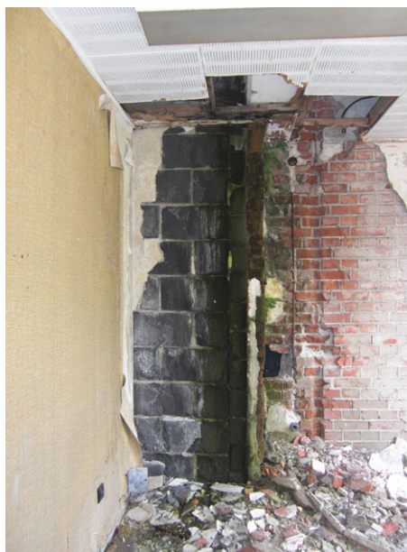
Bild 6. Hus G - blåbetong plan 2, 2008-09-02.
