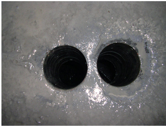
Bild 13. B201btg - borrat genom golv, kryptgrund under, 2008-10-29.
