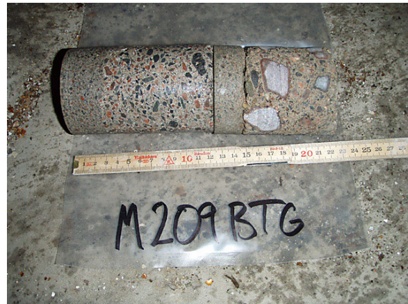
Bild 14. M209btg, golv omgjutet 1 gång, 2008-09-24.
