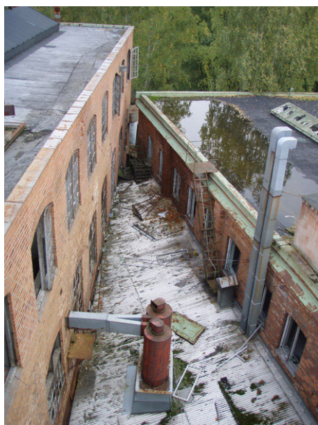
Bild 3. Hus H - taket på skjulet mellan hus H och hus K, 2008-09-23.
