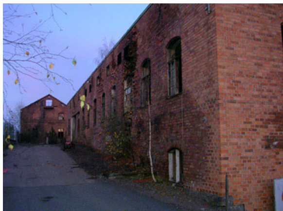
Bild 1. Hus B - västra sidan, 2008-10-29.
