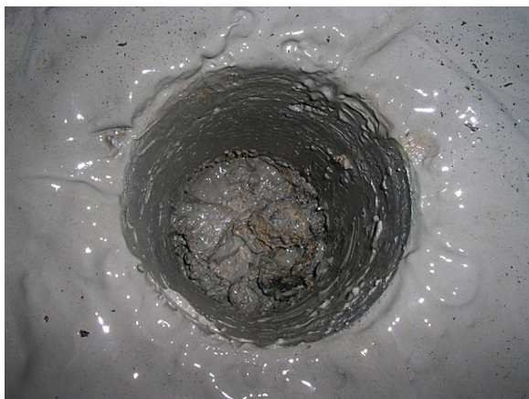
Bild 11. M105btg, makadam under golv, 2008-10-28.
