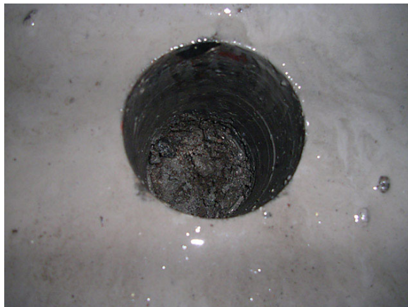
Bild 13. H005btg blandat grus och sand under golv, 2008-10-28.
