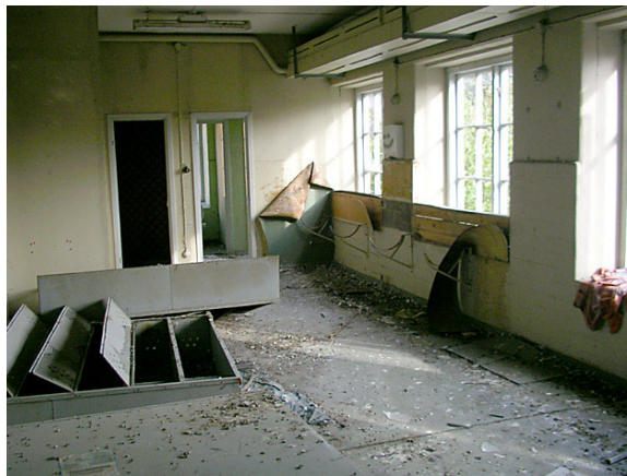
Bild 4. Hus L - plan 2, omklädningsrum, 2008-09-02.
