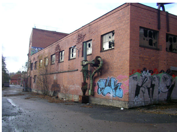
Bild 1. Hus E - från nordväst 2008-10-28.
