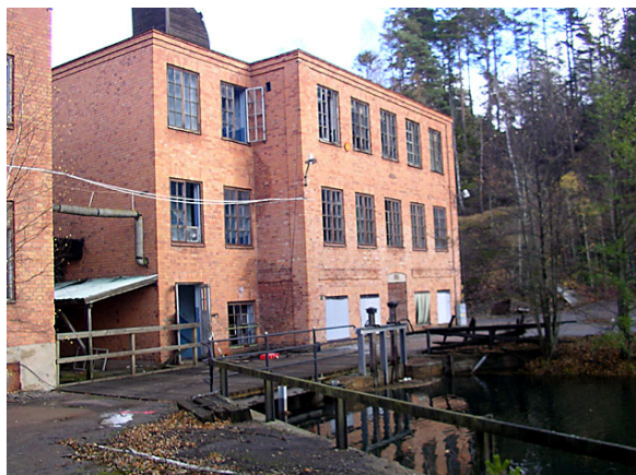
Bild 1. Hus M - från sydost, 2008-10-28.
