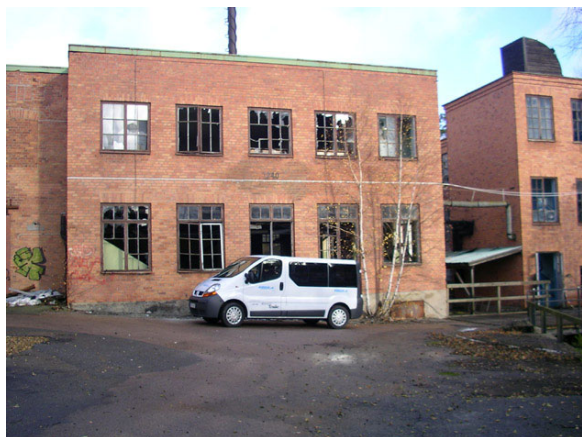
Bild 1. Hus L - från söder, 2008-10-28.
