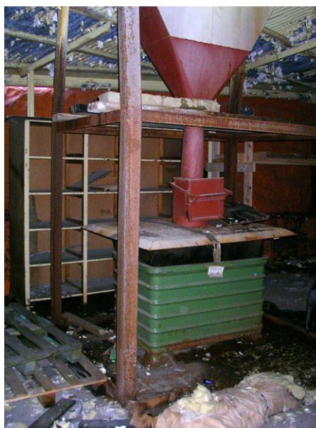
Bild 10. Hus H - uppsamling av metallspån i skjulet, 2008-09-02.
