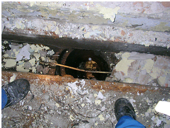
Bild 9. Hus M - utlopp från avloppsränna, 2008-10-29.
