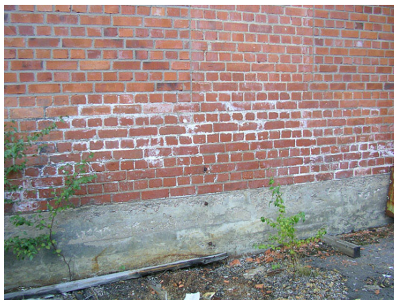
Bild 4. E104tg - utfällningar på vägg 2008-09-02.
