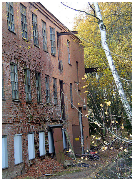
Bild 2. Hus N - östra sidan längst bort i bild, 2008-10-28.
