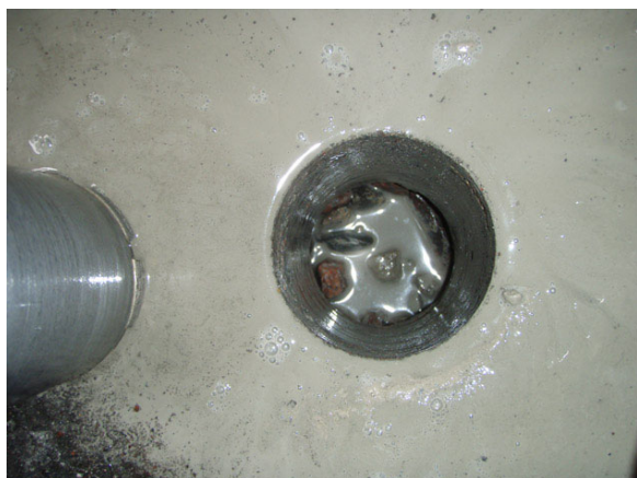
Bild 11. B110btg, - makadam under betong 2008-10-29.
