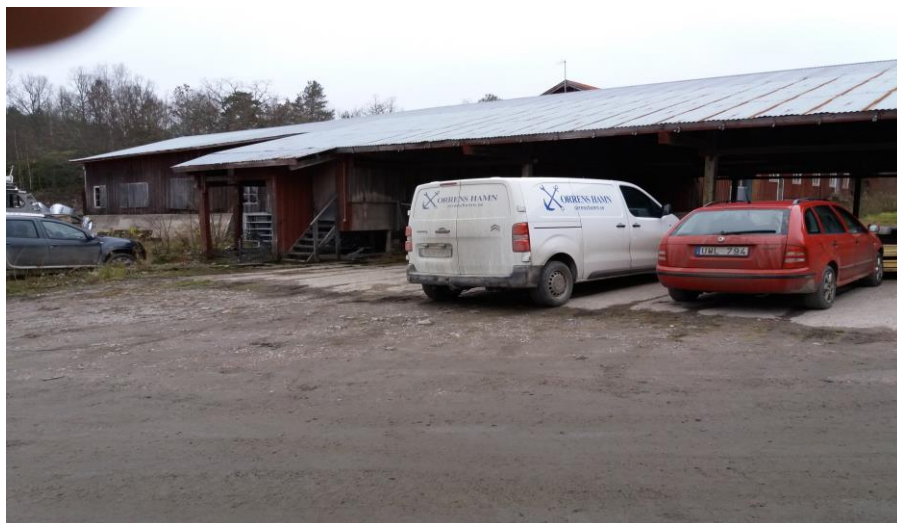
Den gamla sågverksbyggnaden, fasad mot öster
