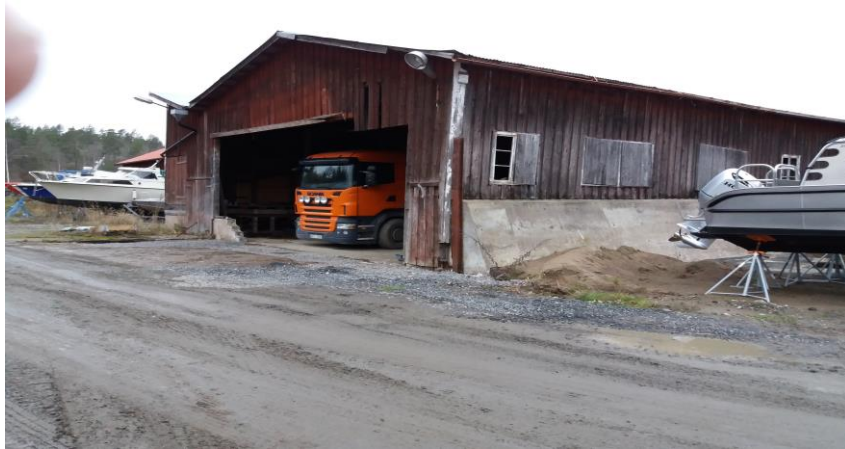
Den gamla sågverksbyggnaden, fasader mot öster och söder
