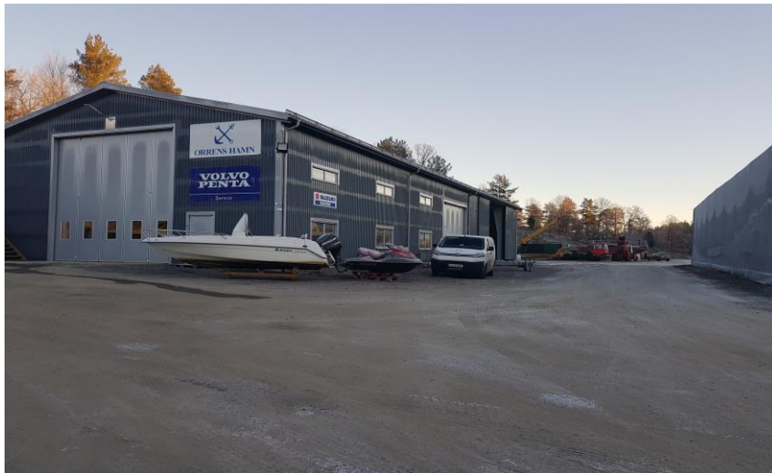
Nyuppförd båtverkstad, fasader mot sydost och sydväst
