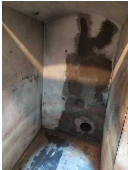
Figur 6. Utrymmet rakt framöver från ingången. De mörka fläckarna är vatten/fukt på smutsig yta.
