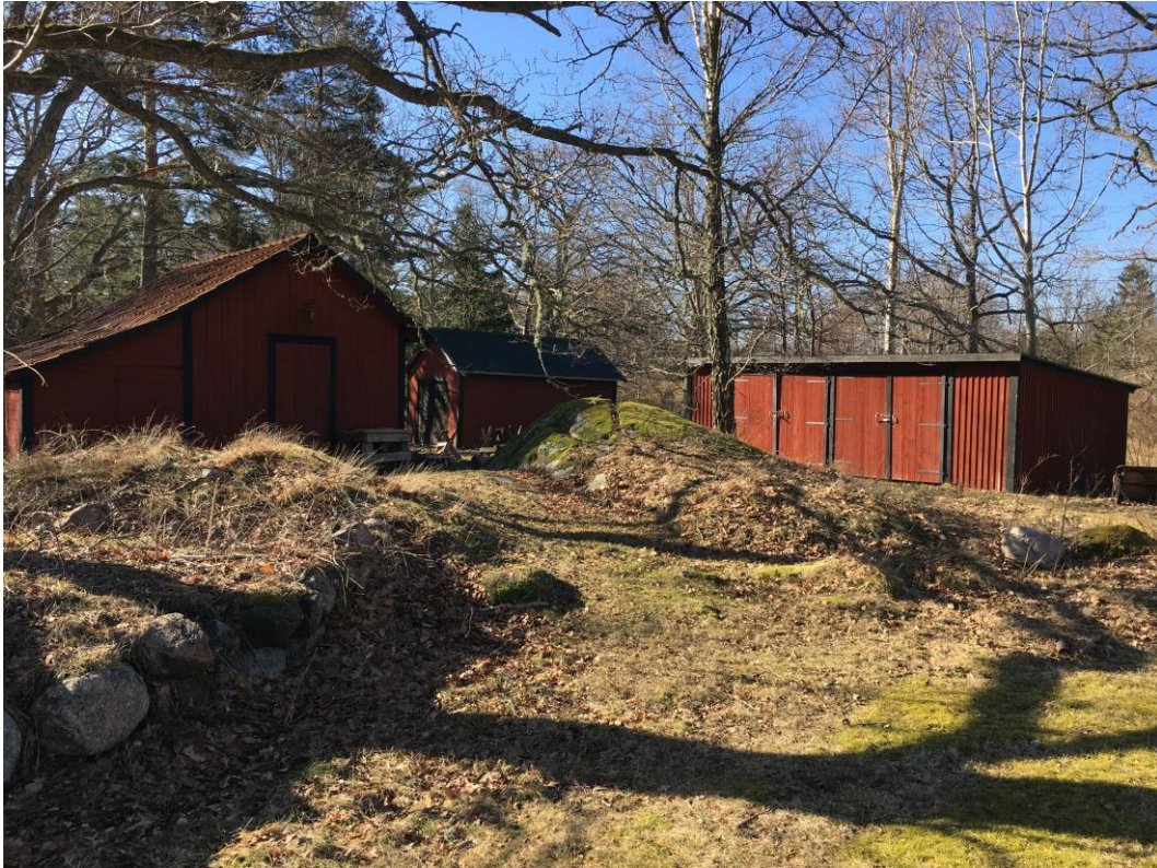
Figur 11. Tre mindre ekonomibyggnader belägna straxt utanför det som tidigare var åkermark enligt Laga skifteskartan. I bildens mitt syns en anlagd körväg som går över ett impediment som också låg utanför den tidigare åkermarken. Till vänster om körvägen finns tillrättalagd odlingssten i form av en uppmurad kant till gräsmattan. Sannolikt ett verk av trädgårdsmästaren. Foto: Hans Antonson, 2018.
