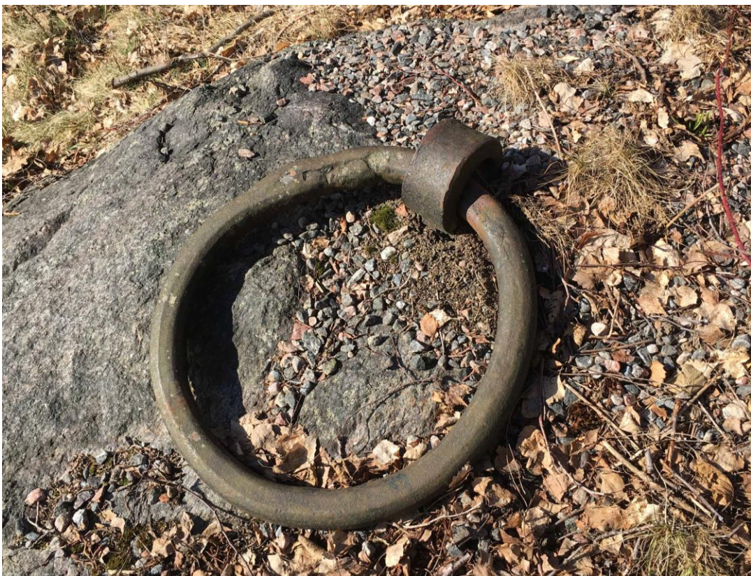
Figur 8. Detalj av moringen på fastighet Kättilö 1:34. De ihopvälda ändarna syns tydligt. Foto: Hans Antonson, 2018.
